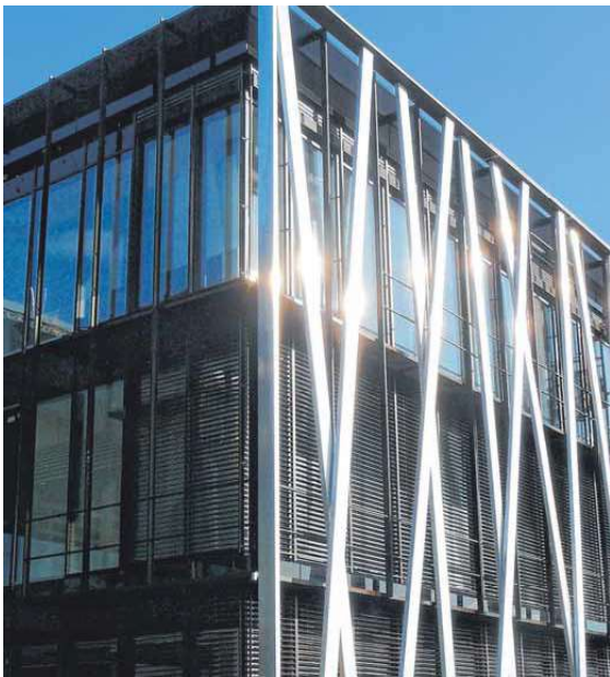
Die Konzmann GmbH ist in der obersten Etage des neuen Gebäudes zu finden.
